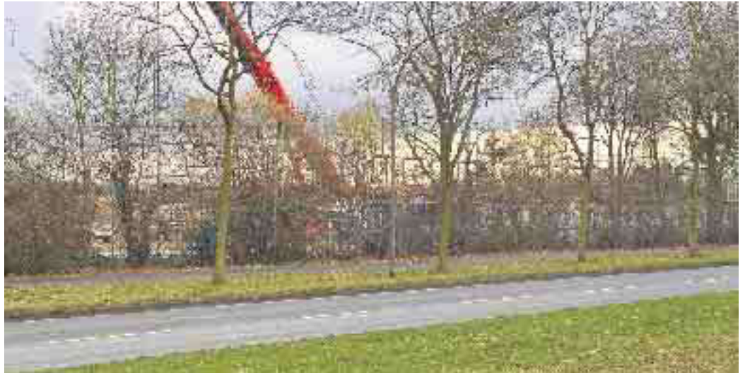
Die Baustelle am Neubrücker Ring Foto: PM
